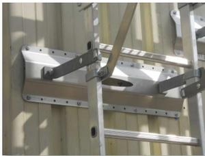
Fixation de la plaque par l'extérieur du bardage pour éviter les coupes et préserver l'étanchéité
