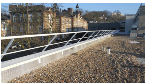
Garde-corps toiture inaccessible
