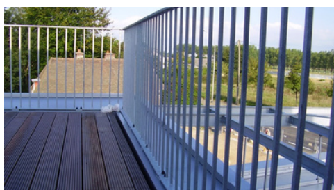
Garde-corps terrasse accessible
