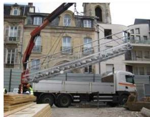
Rapidité de montage au sol, transportable pré monté et grutable
