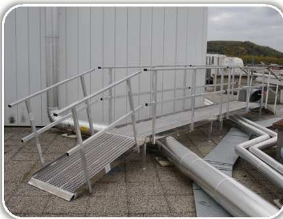
Rampe d'accès avec garde corps gauche et droit
